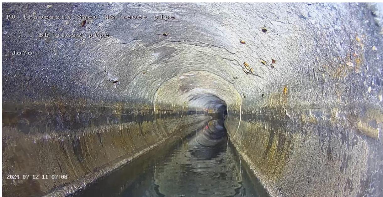
**Figura 2:** Trecho a jusante da possível obstrução (baixa vazão do esgoto).
