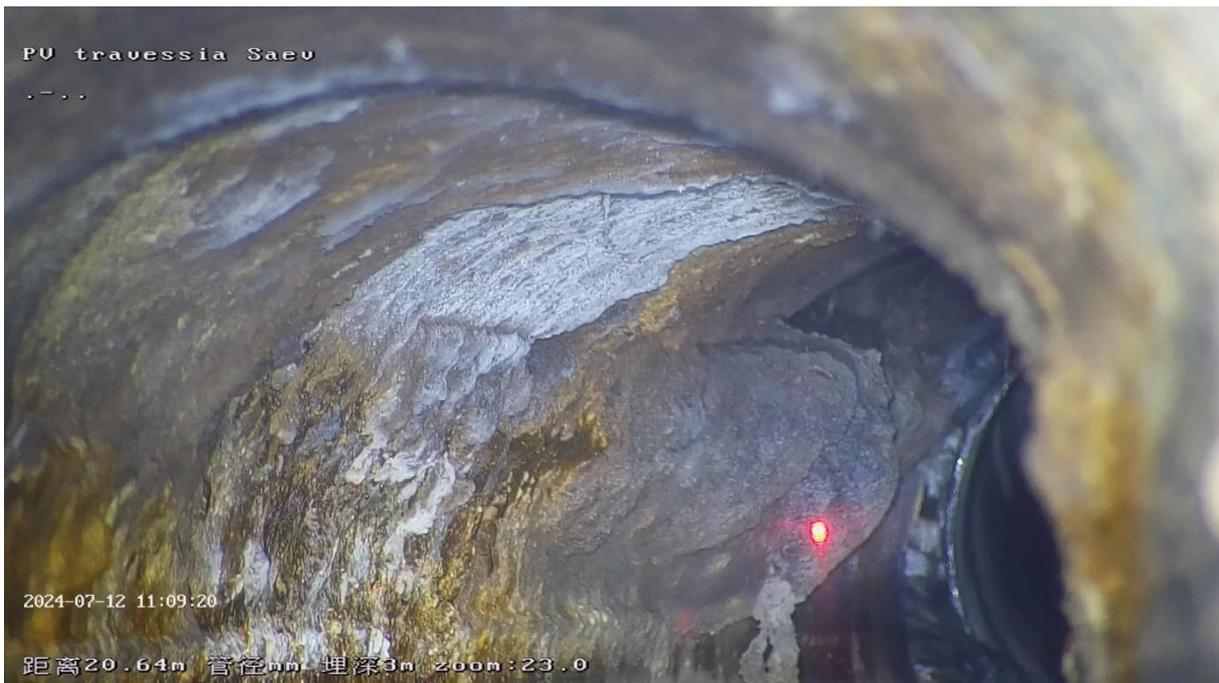
**Figura 3:** Filmagem no sentido da jusante para montante (curva ou deslocamento da tubulação).
